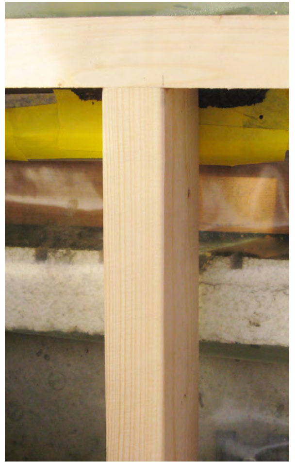
Dampspærre ved eksisterende isolering på tag
