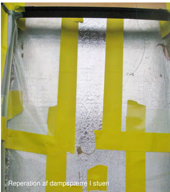
Defekt dampspærre på 1. sal
