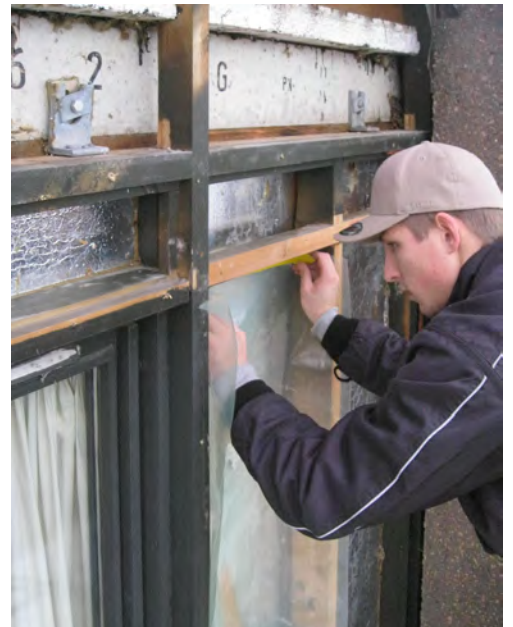
Galgebakken mock-up af facade 20. november 2014
