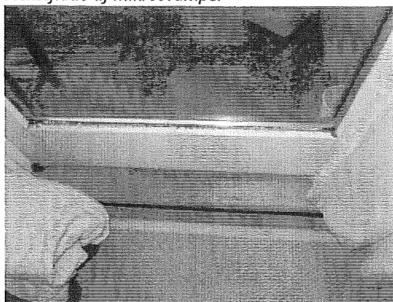
Fotos 6. Stue. På væg ved hoveddør i stue sås mikrosvampevækst. Vinduer og døre var mørk misfarvet især på ramme-/karmbund som indikation på fugt og mulig vækstflade af mikrosvampe.
