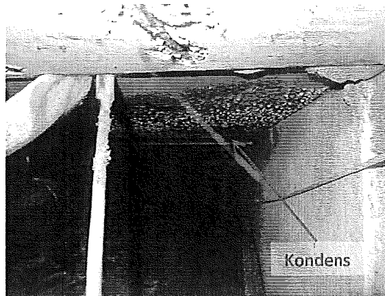
Fotos 1. Gang i krybekælder under sti. Vue fra krybeklæder under bolig. Kraftig kondens ses i loft under sti, og der ses rust på armeringsjern.
