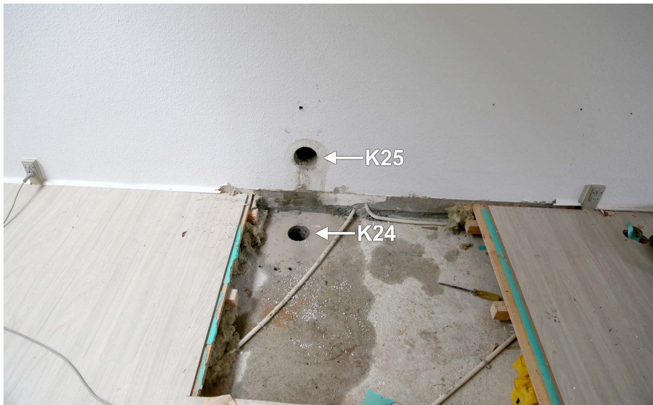
Skrænten 1, 9A. Placering af de udborede kerner K24 og K25 fra henholdsvis dækkelement og bagvægselement. Begge kerner blev udboret umiddelbart op til den lave sokkel hvorfra kerne K1 og K2 blev udboret
