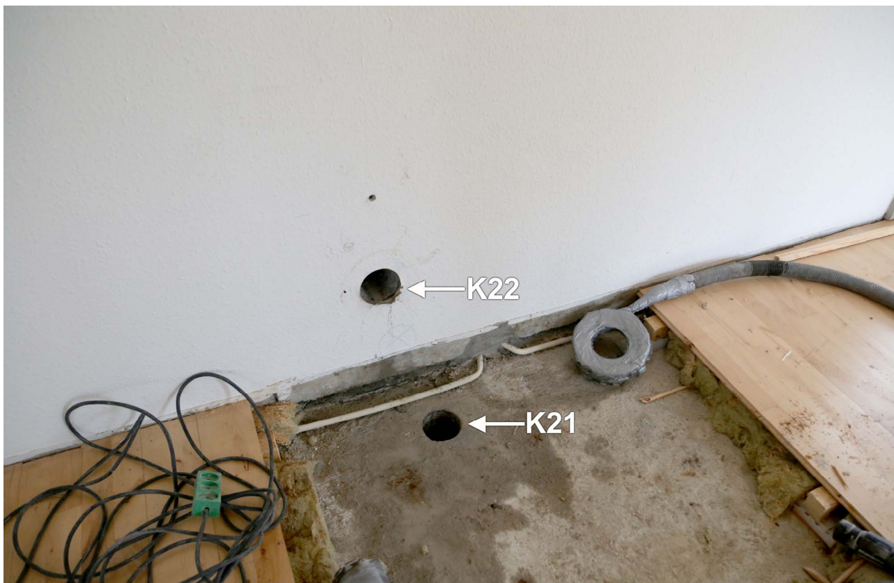
Mark 2, 8A. Placering af de udborede kerner K21 og K22 fra henholdsvis dækelement og en indvendig tung væg
