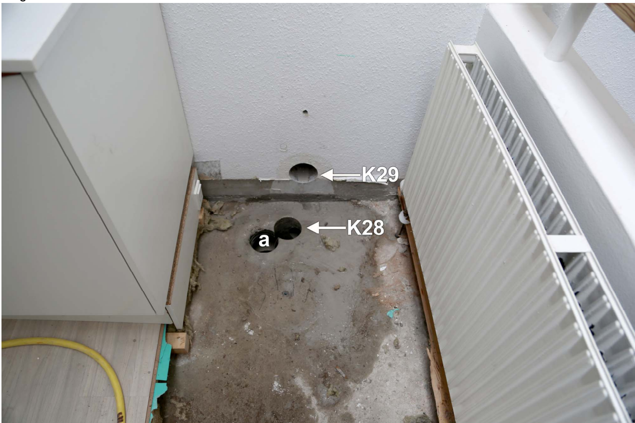
Skrænten 1, 9A. Placering af de udborede kerner K28 og K29 fra henholdsvis dækelement og bagvægselement. Begge kerner blev udboret umiddelbart op til den høje sokkel, hvorfra kerne K3 til K6 blev udboret. Der blev udført et mislykket forsøg på kerneudboring (a)
