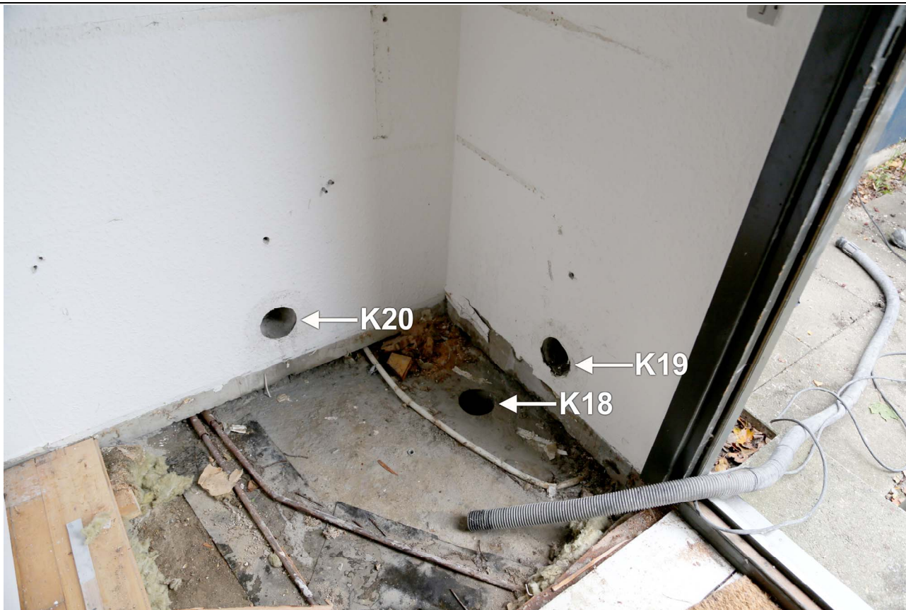
Mark 2, 8B. Placering af de udborede kerner K18, K19 og K20 fra henholdsvis dækelement, bagvægselement og indvendig tung væg. Alle kerner blev udboret umiddelbart op til den lave sokkel hvorfra kerne K7 og K8 blev udboret.
