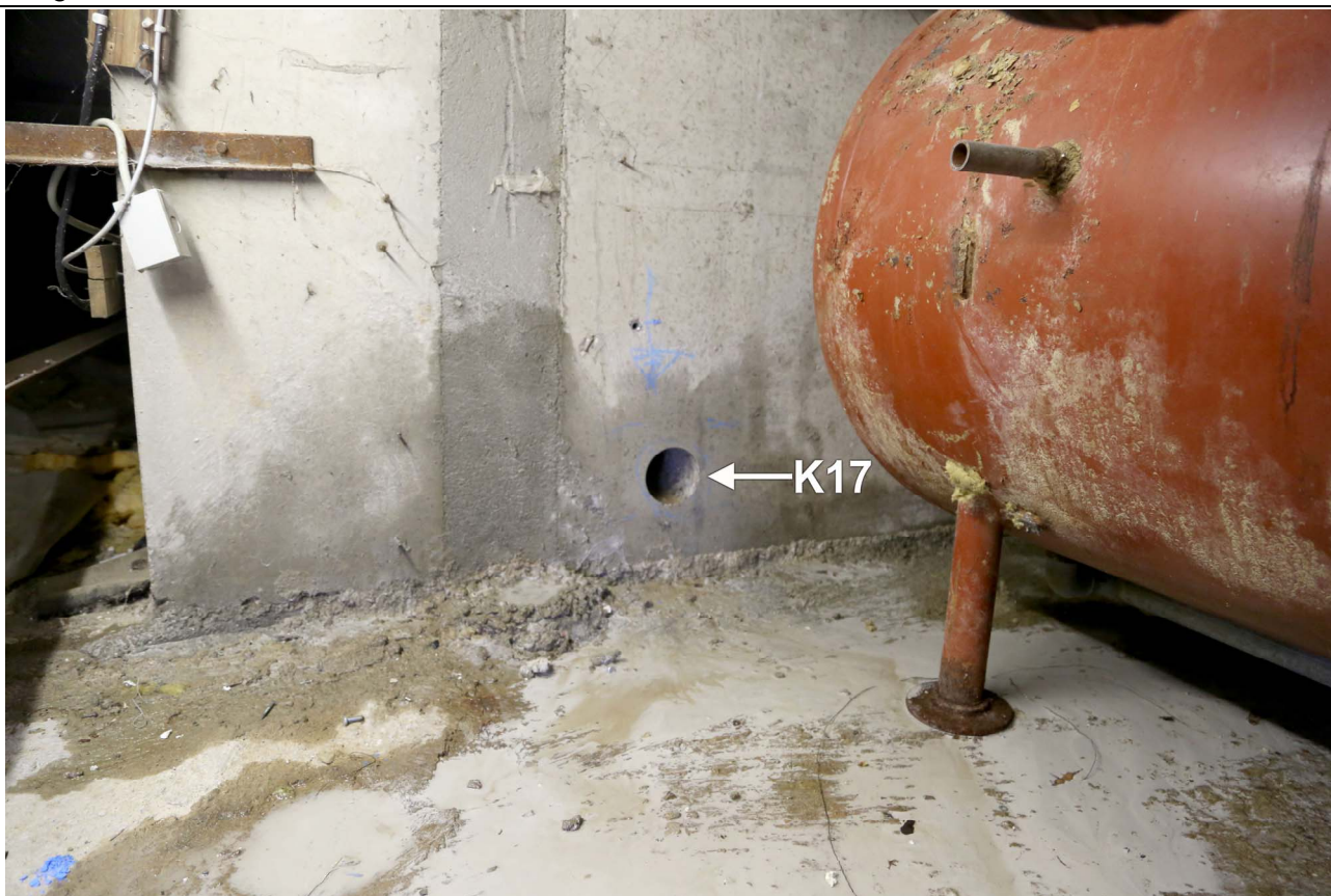
Torv 7, 1A. Placering af den udborede kerne K17 fra indvendig sokkel i krybekælder
