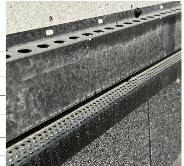
Alu.profil på forsiden af fiberbeton
