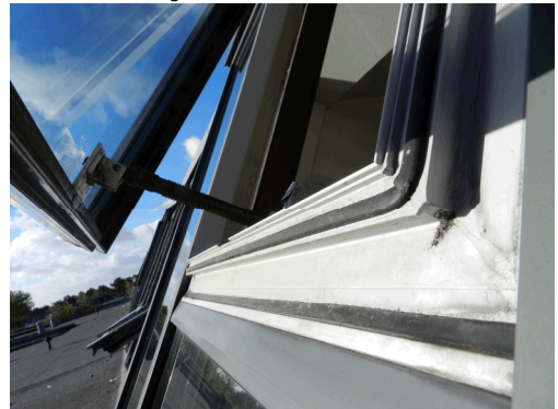
Type AV- Ateliérvindue. Ramme er relativ spinkel, risiko for skævvridning
