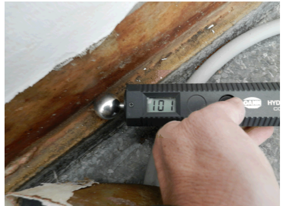
Vester 4-11, C-bolig – Opfugtning bag PVC-listen
