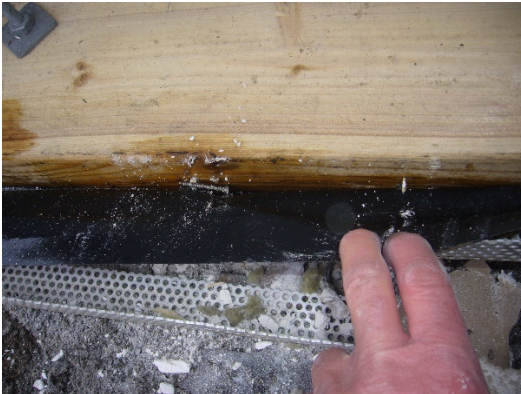
Bundrem under vinduesparti – synligt vand, men kun opfugtet på forkant
