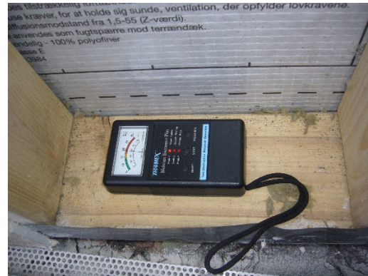
Bundrem i felt tv for vinduesparti – ikke opfugtet
