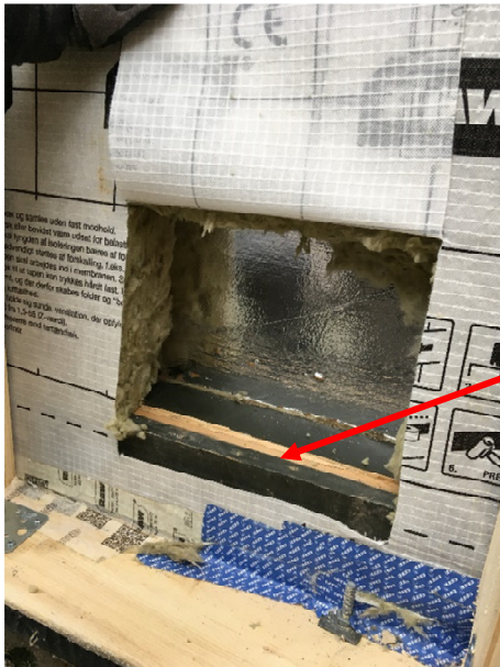
Dampspærre og isolering bag denne demonteret
