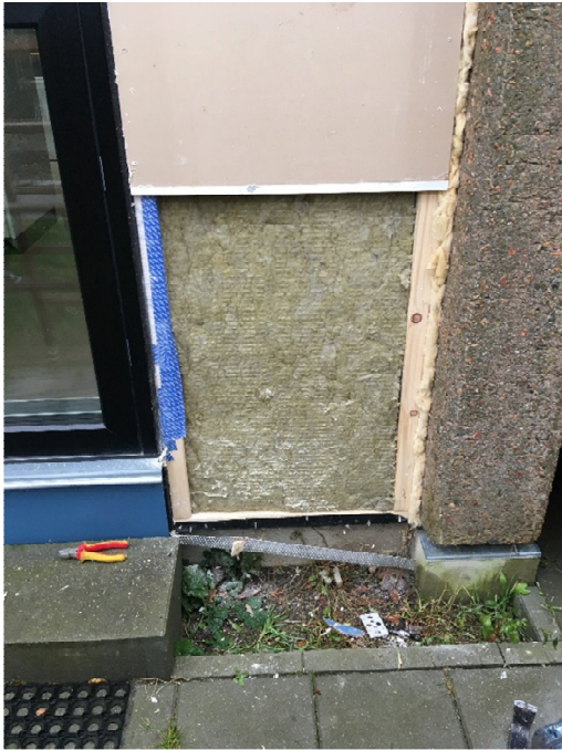
Nederste facadeplade demonteret – isolering monteret med tætte stød – ingen synlig fugtpåvirkning
