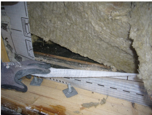
Hultagning i ny dampspærre med bagvedliggende isolering
