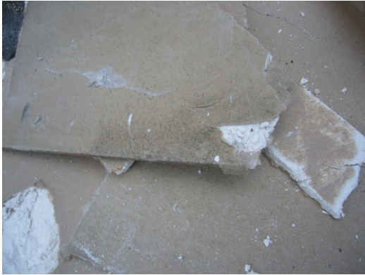
Vindgips synligt fugskadet med let angreb af skimmel
