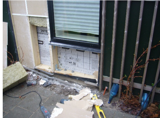
Felt under vindue – ny dampspærre blotlagt
