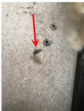
Billede 1: Isolering bag vindstopplader skal betragtes som asbestforurenet pga. gennemboring af asbestholdigplade ved fastgørelse af træespalier.
