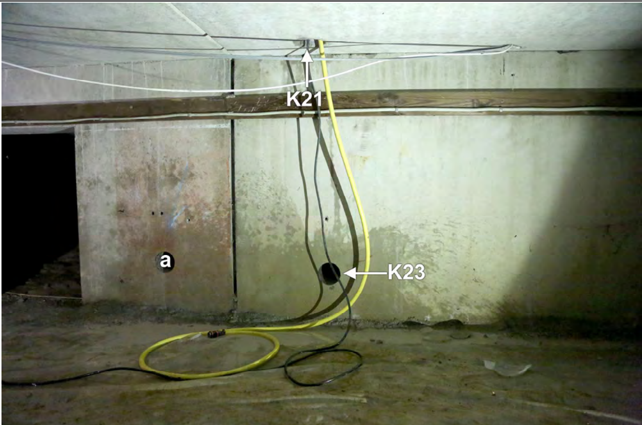
Mark 2, 8A. Placering af de udborede kerner K21 og K23 fra henholdsvis dækelement og indvendig sokkel i krybekælder. Der blev udført et mislykket forsøg på kerneudboring (a)
