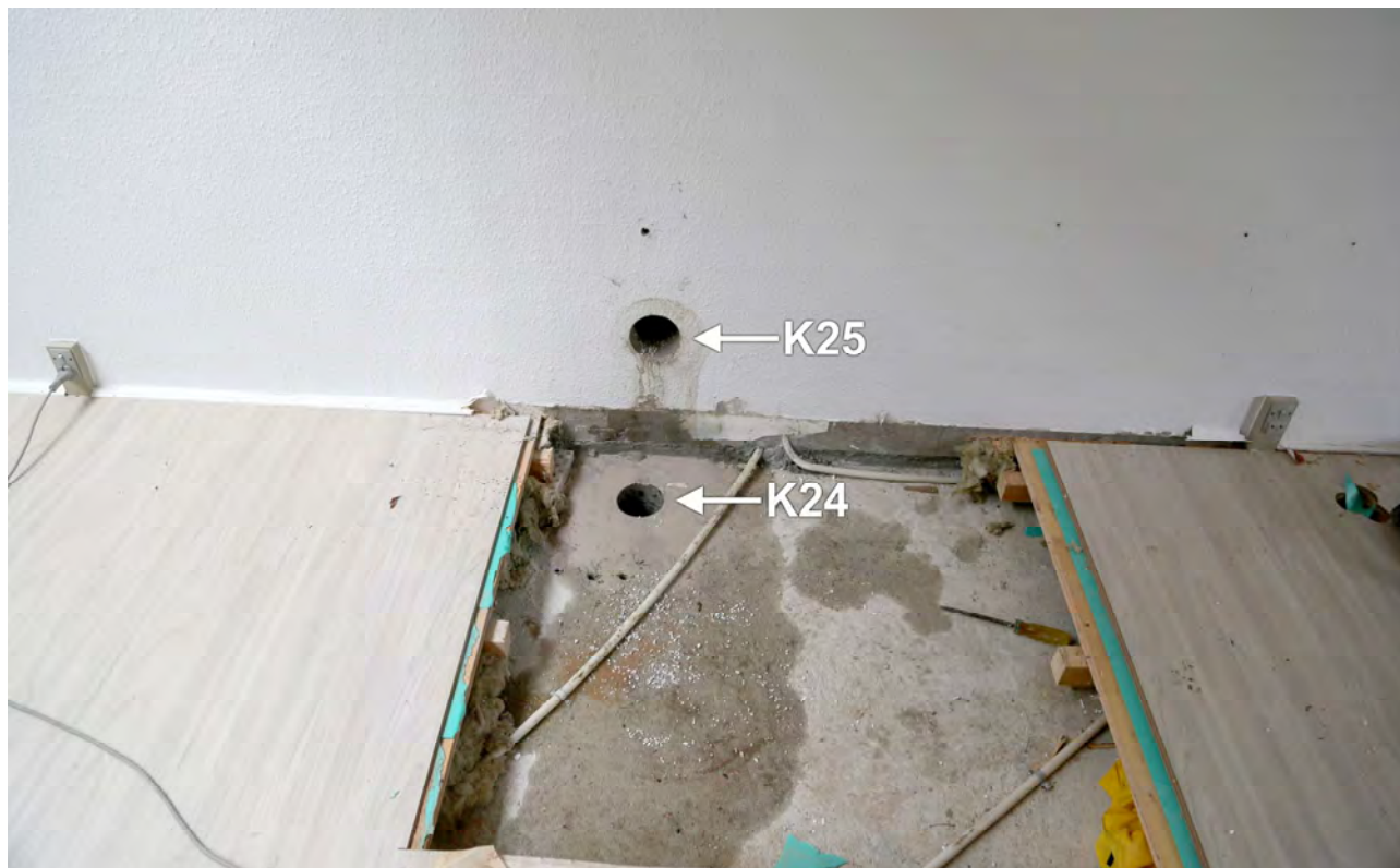
Skrænten 1, 9A. Placering af de udborede kerner K24 og K25 fra henholdsvis dækelement og bagvægselement. Begge kerner blev udboret umiddelbart op til den lave sokkel hvorfra kerne K1 og K2 blev udboret
