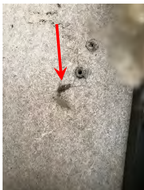
Billede 1: Isolering bag vindstopplader skal betragtes som asbestforurenet pga. gennemboring af asbestholdigplade ved fastgørelse af træspalier.
