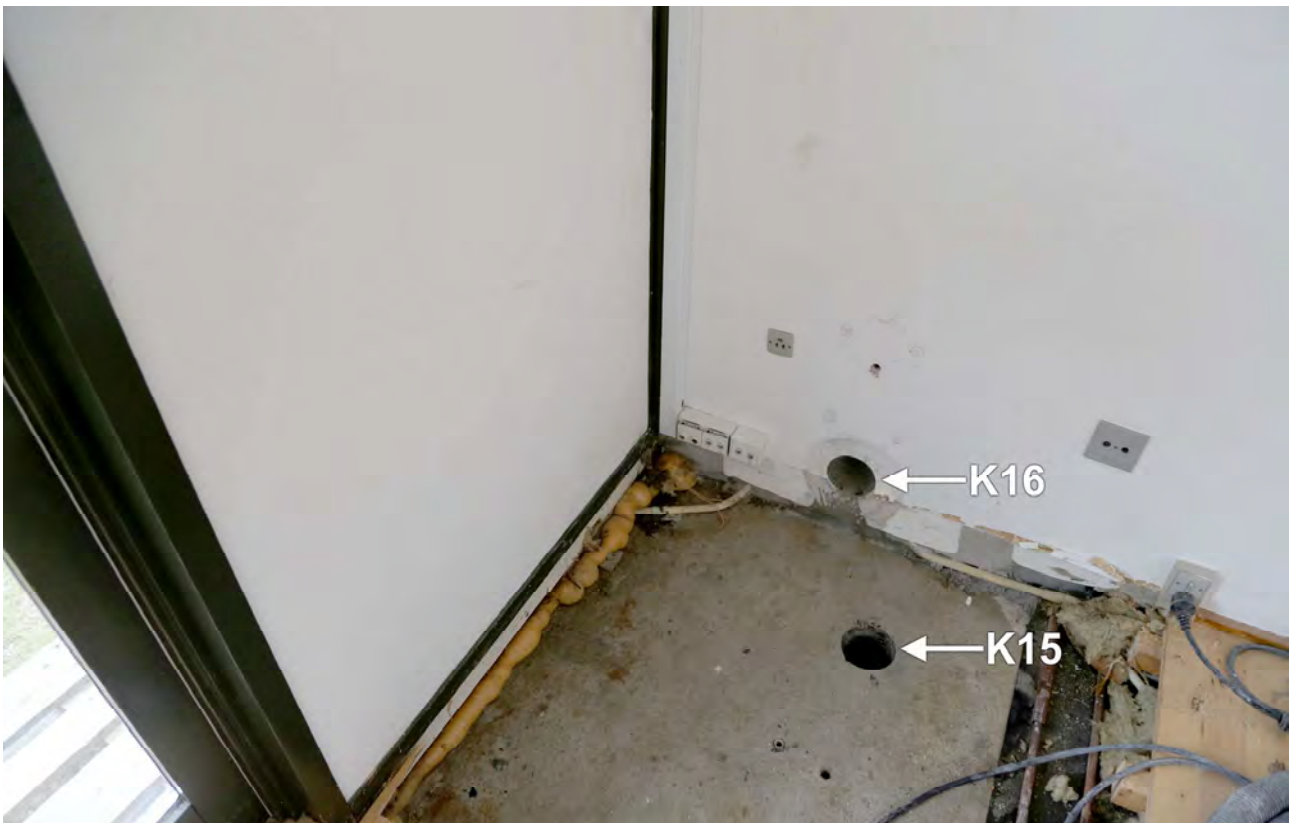
Torv 7, 1A. Placering af de udborede kerner K15 og K16 fra henholdsvis dækelement og indvendig tung væg
