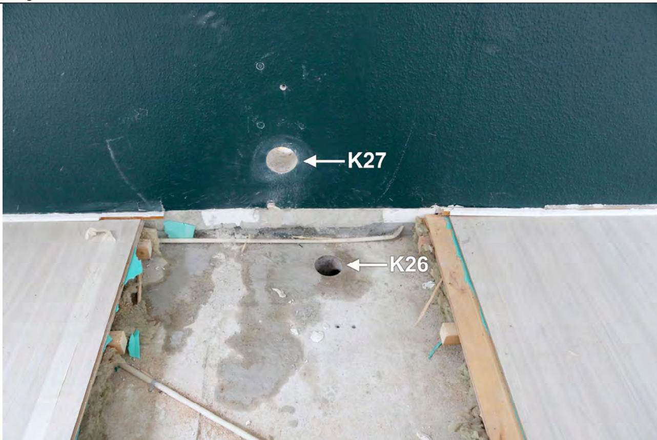
Skrænten 1, 9A. Placering af de udborede kerner K26 og K27 fra henholdsvis dækelement og indvendig tung væg
