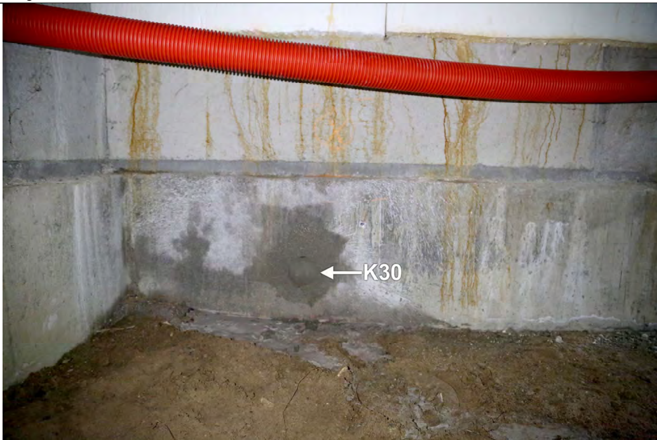
Skrænten 1, 9A. Placering af den udborede kerne K30 fra en indvendig sokkel i krybekælderen
