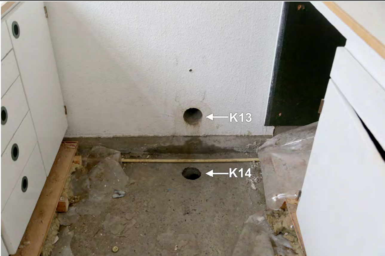
Torv 7, 1A. Placering af de udborede kerner K13 og K14 fra henholdsvis bagvægselement og dækelement. Begge kerner blev udboret umiddelbart op til den høje sokkel hvorfra kerne K9 til K12 blev udboret
