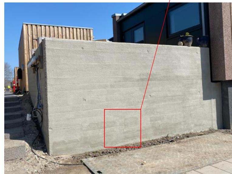
Færdigbehandlet med grå mørtelsvumning
